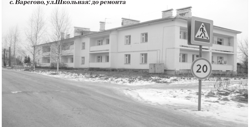
с. Варегово, ул.Школьная: до ремонта
