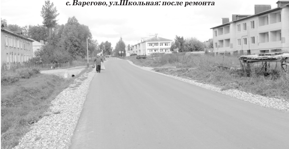
с. Варегово, ул.Школьная: после ремонта
